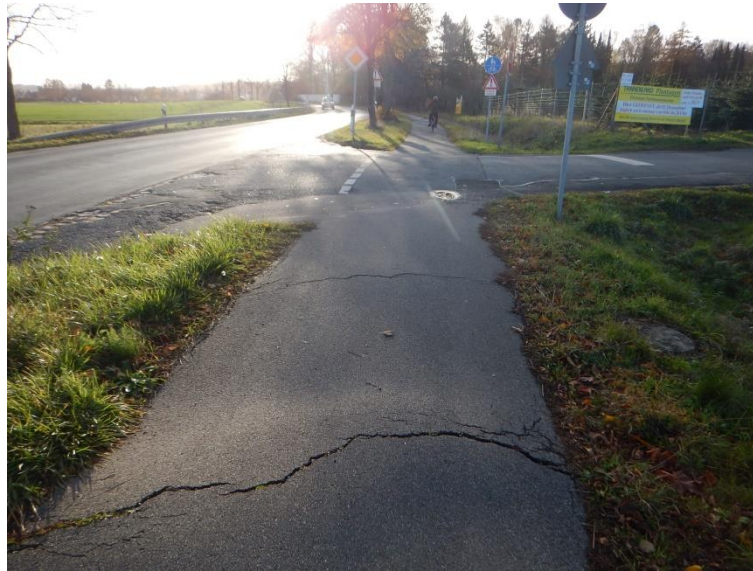
Foto 14 Wurzelfaßbrüche auf dem straßenbegleitenden Radweg an der L 391 zw. Hohenbostel und Barsinghausen
