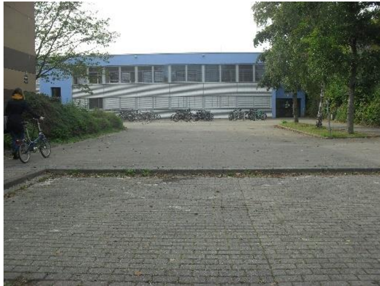
Foto 9 Zugang zur der nordseitigen Abstellanlage - Schulzentrum Am Spalterhals
