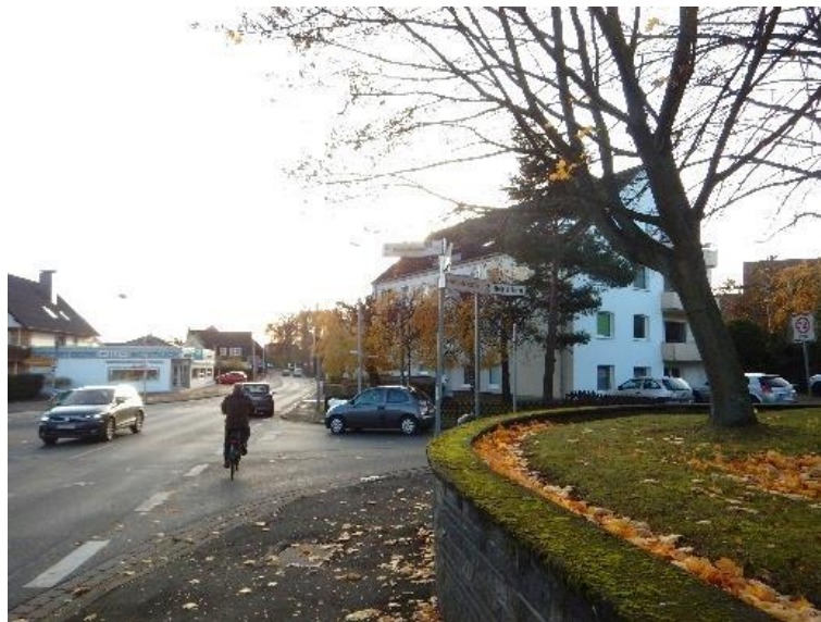
Foto 12 Ungesicherter Übergang von der Gehwegnutzung auf die Fahrbahn
